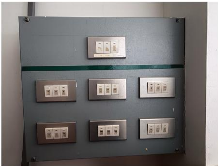
ภาพที่ 45 แผงสวิตช์ไฟ ไฟส่องสว่างในห้องประชุม ที่มา : (ภาพถ่ายโดยผู้เขียน, 2569)
